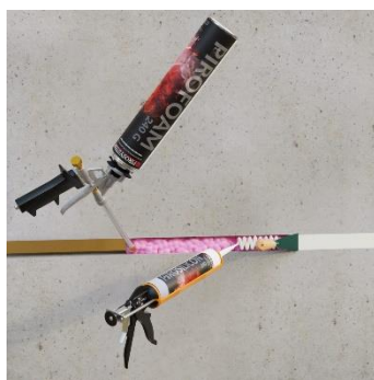
Pustą przestrzeń wypełnij Piro Foam 240 i nałóż warstwę PIROSILICON 240 po obu stronach ściany
